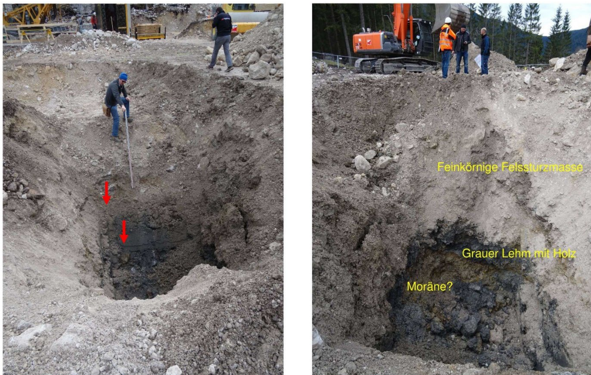
Abb. 2: Schurfschlitzte Talstation Seilbahn Zugspitze am Eibsee
